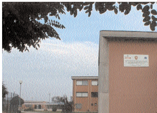
Una veduta complessiva della nuova sede
